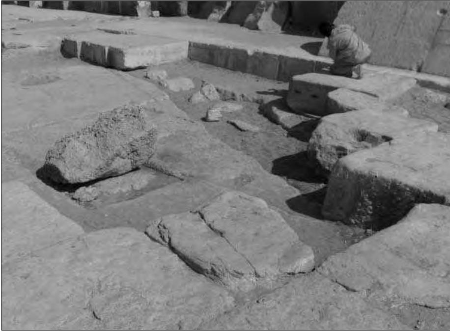
*Die Bodenplatten sind nicht nur millimetergenau zugeschnitten, sie wurden auch dem felsigen Untergrund genau angepasst (Cheopspyramide, Nordseite).*
