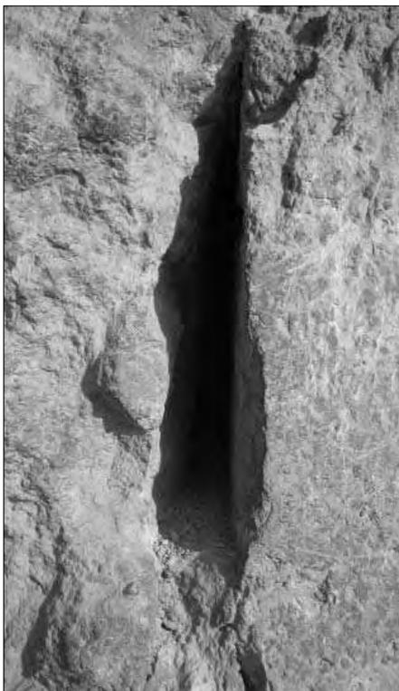
*Zwischenraum zwischen zwei Außensteinblöcken der Chephren-Pyramide. Man erkennt, dass die Spalte einst ganz mit Mörtel ausgefüllt war. Ein Rest ist noch unten in der Spalte sichtbar.*
