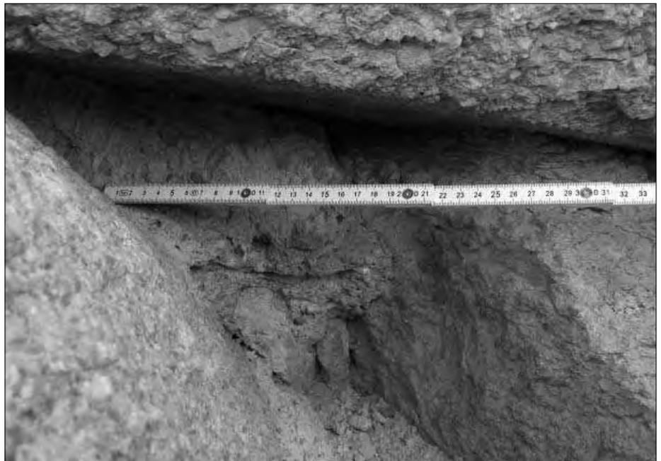
*Die Mykerinos-Pyramide wurde im Vergleich zu den beiden größeren Pyramiden regelrecht zusammengeschustert! Größere Zwischenräume zwischen den Steinblöcken hat man mit einer Art Mörtel zugeschmiert.*
