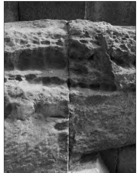
beschädigten Stellen kann man sehen, dass die Platten unterschiedlich dick sind. Das heißt, dass jede einzelne Platte vor ihrem Verlegen dem felsigen Untergrund angepasst werden musste.
