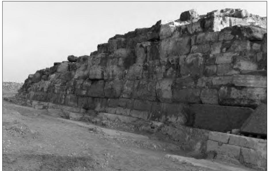
*Von der Djedefre-Pyramide bei Abu Roasch sind gerade mal ein paar der untersten Steinlagen übrig. Die Bauarbeiter waren nicht wählerisch und verbauten die Steinblöcke, wie sie kamen: Sandsteine, Granitblöcke, große, kleine, nach dem Motto: „Was nicht passt, wird passend gemacht!“. Präzision war nicht gefragt, man erkennt es an den mit Mörtel gefüllten Zwischenräumen.*
